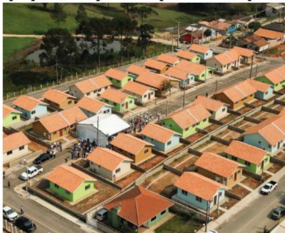
Construção das 240 moradias será executada pela Cohapar
