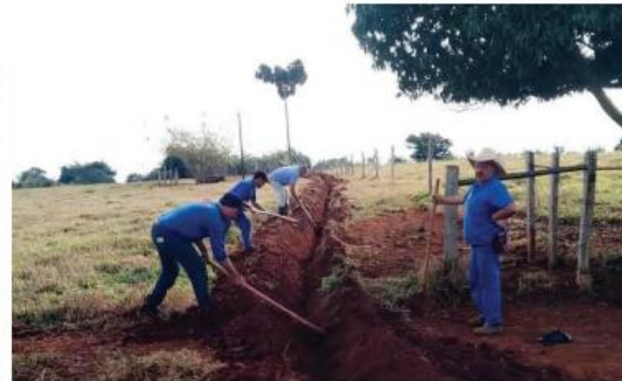
Com uma tubulação de quase 1 km até o bairro e um reservatório de 20 mil litros, moradores terão acesso à água encanada
