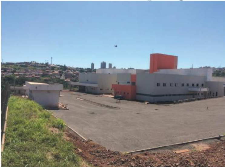
Hospital Regional de Cornélio Procópio está praticamente concluído
